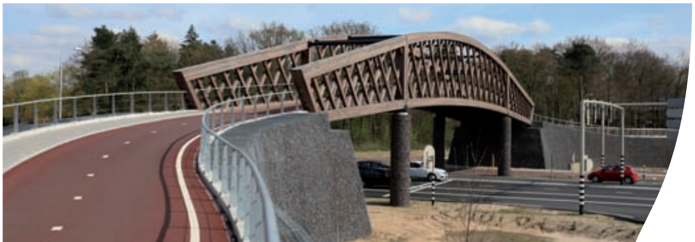
Figuur 2 - Architectonische houten fietsbrug over de N302.
