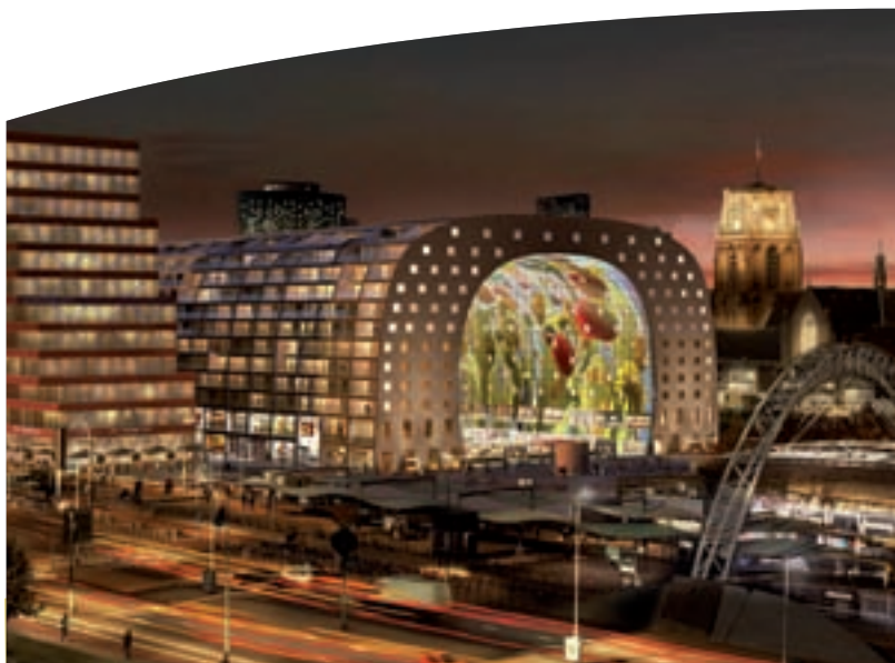
De Markthal (in aanbouw) te Rotterdam.
