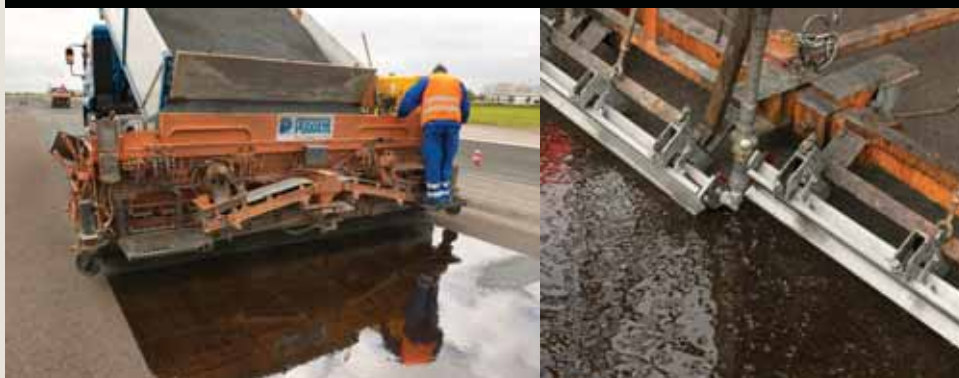
Aanbrengen van de slijtlaag, die bestaat uit drie componenten.
