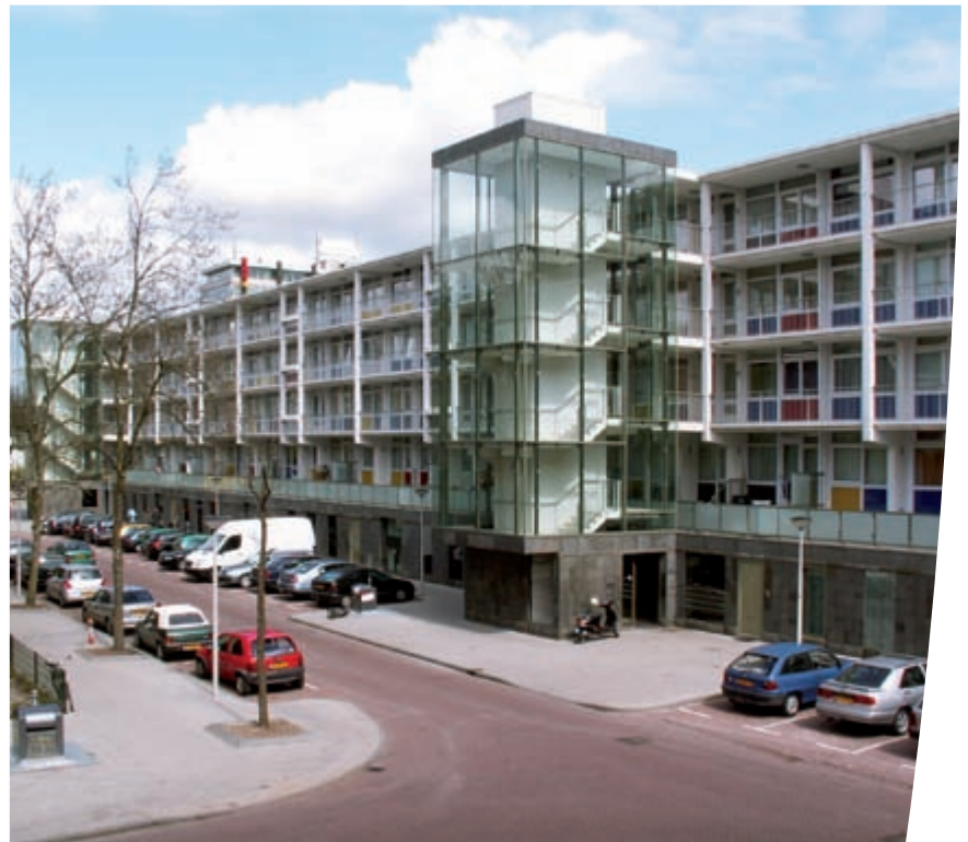
Figuur 4 - Beeldkwaliteit: Complex de Verfdozen te Amsterdam na renovatie (architect Van Schagen), voorzien van nieuwe lift-/trappenhuisen en galerijen.
