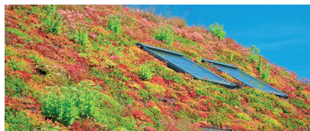
Figuur 4 - Sedum op een schuin dak.
