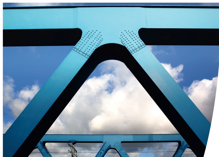
Figuur 5 – Vakwerkliggers Calandbrug.
