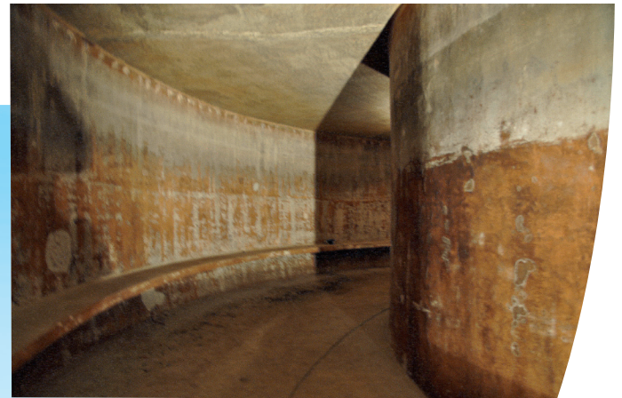
Figuur 2 - Foto bestaande waterkelder.
